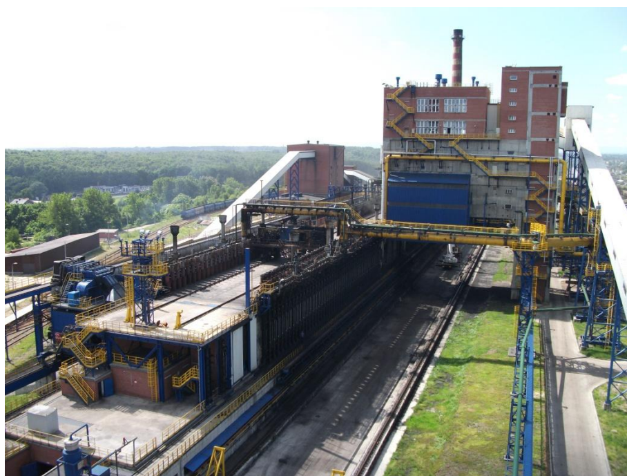
Fot. Widok ogólny Koksowni „Radlin” w Radlinie (źródło: JSW SA Kombinat Koksochemiczny „Zabrze”)
