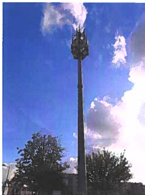
Stacja bazowa telefonii komórkowej wolnostojąca
