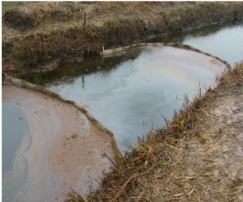
Fot. 3. Rów melioracyjny. Zapory przeciw rozlewowe. Widoczne ślady węglowodorów i sorbentu.
