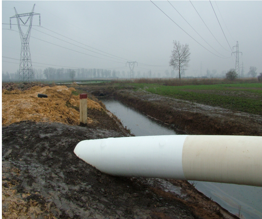
Fot. 3. Rów melioracyjny. Zapory przeciw rozlewowe. Widoczne ślady węglowodorów i sorbentu.
