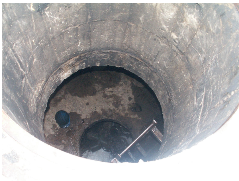
Fot. 1. Właz do rozdzielni przepływu paliwa.
