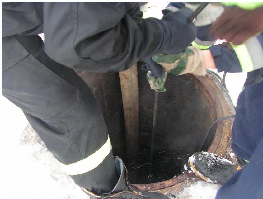
Fot. 2. Rozdzielnia przepływu paliwa – włącz.
