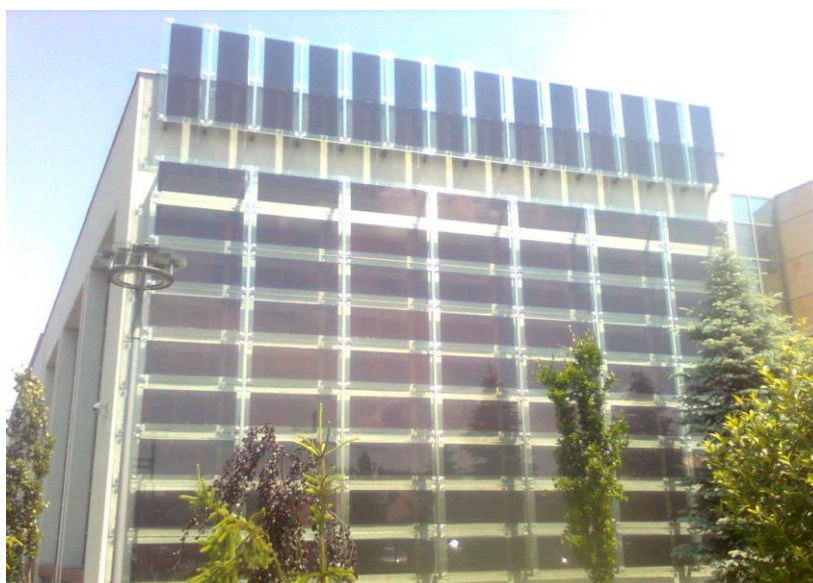
Fotografia 2.1. Instalacja ogniw fotowoltaicznych w WSPiA Rzeszowskiej Szkole Wyższej (GIOŚ/RWMŚ w Rzeszowie)
