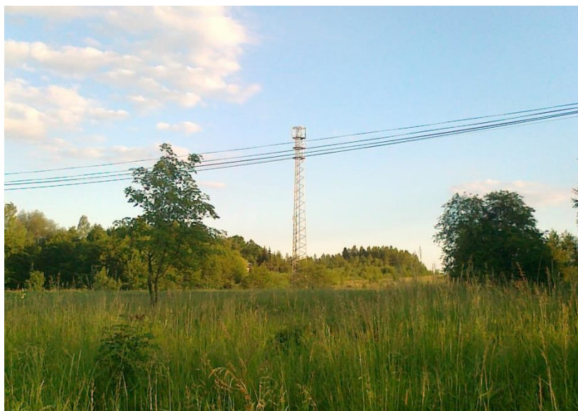
Fotografia 5.1. Stacja bazowa w rejonie m. Albigowa (źródło: GIOŚ/RWMŚ w Rzeszowie)
