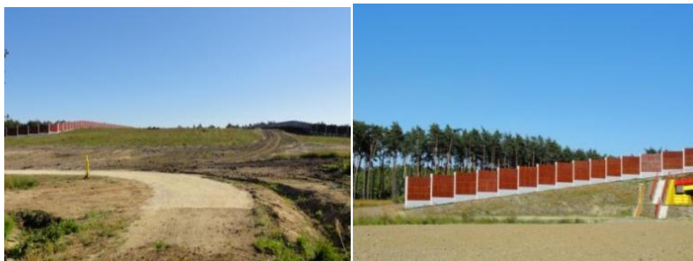
Fot. Przejście dla zwierząt na autostradzie A4 na odcinku Brzesko-Tarnów (T. Prajsnar)
