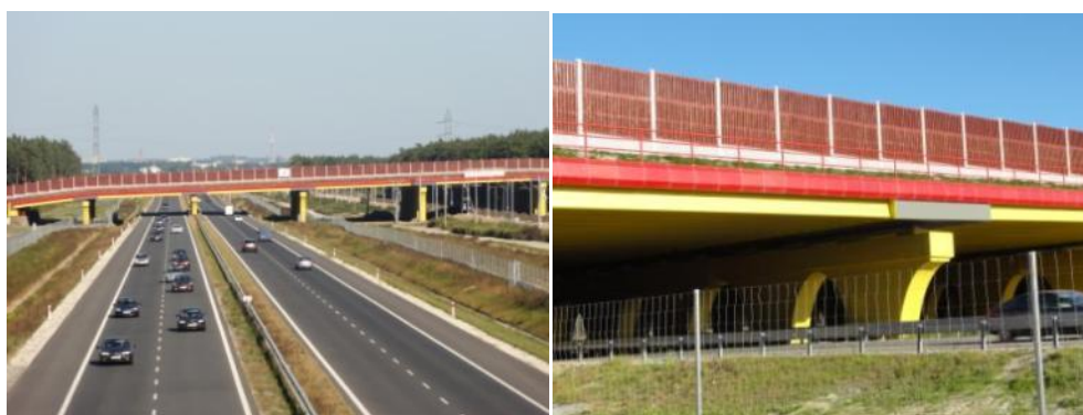
Fot. Zachowanie ciągłości korytarzy ekologicznych i szlaków migracyjnych zwierząt – przejście dla zwierząt na autostradzie A4 na odcinku pomiędzy węzłami Brzesko i Wierzchosławice (Tarnów-Północ) oraz linii kolejowej Kraków-Tarnów (T. Prajsnar)
