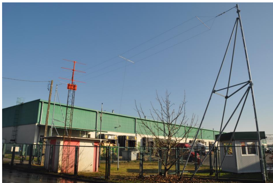
Rys. 3.2.3 Radiolatarnie znakująca systemu ILS ( Instrumental Landing System ) i NDB. Fot. Stefan Różycki
