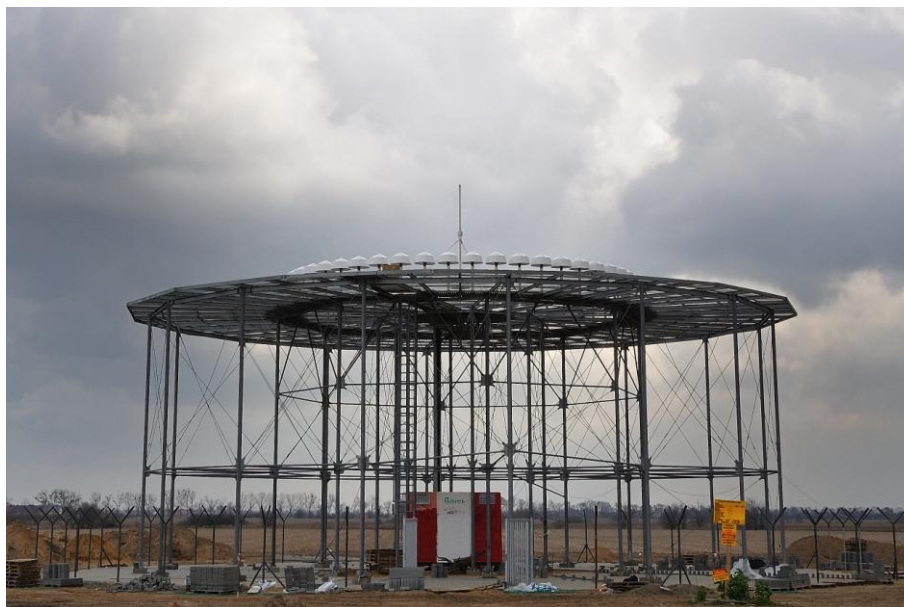
Rys. 3.2.6 Radiolokacyjna stacja VOR w okolicach m. Zaborów. Fot. Stefan Różycki
